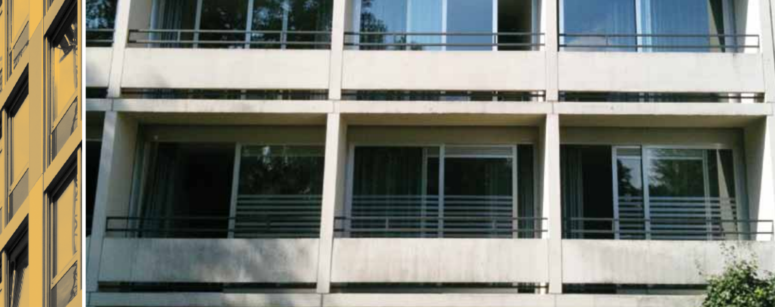
Fassadensituation mit Balkonen vor der Sanierung
